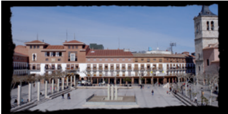
El pavimento era muy resbaladizo y su aspecto poco estético para ser el centro de la ciudad
