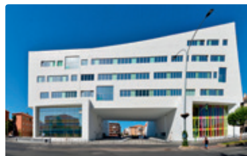
Spa Wellness - Gimnasio - Centro de Seguridad
