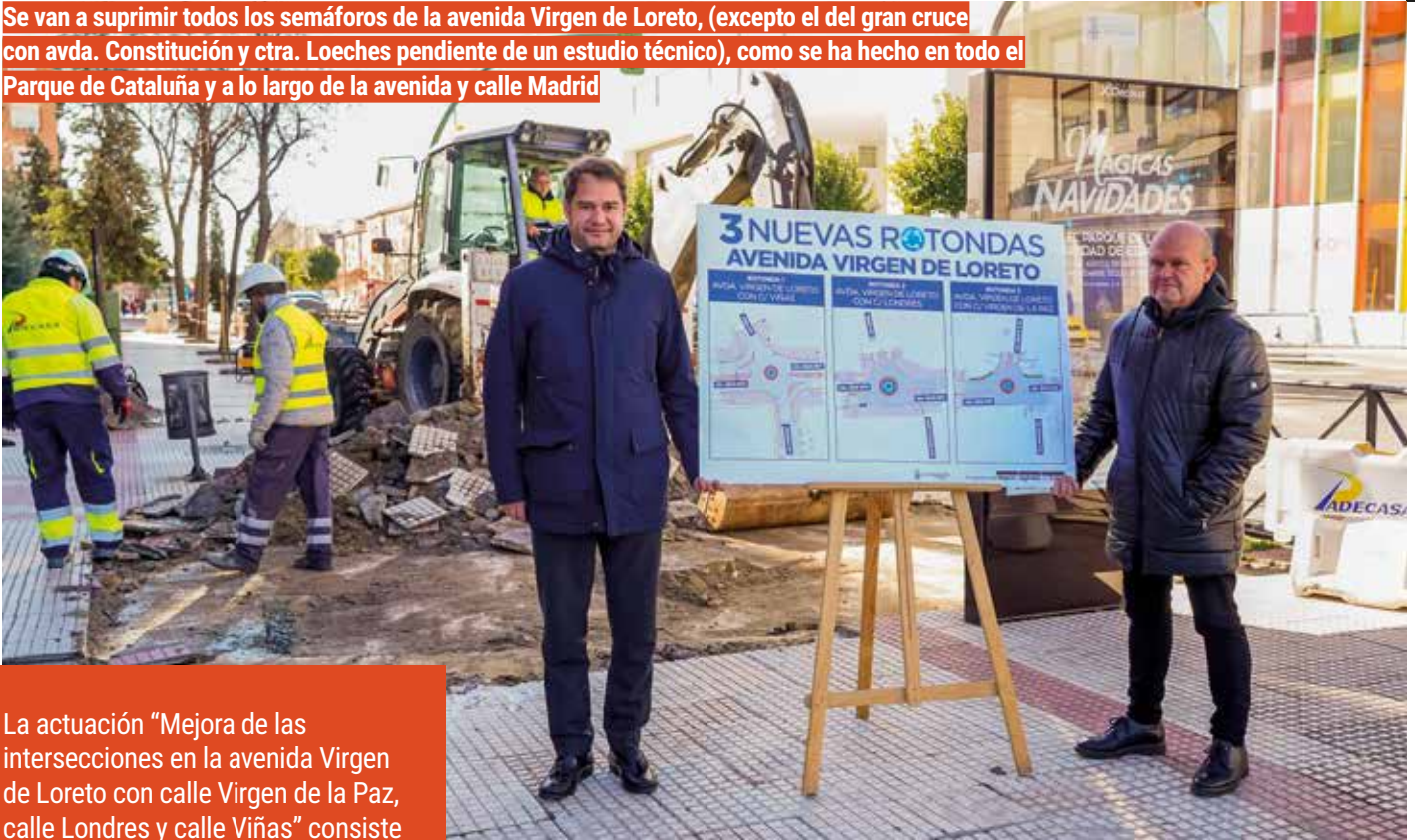
El alcalde, Ignacio Vázquez, y el teniente de alcalde y concejal de Obras, Valeriano Díaz, presentando el inicio de las obras de las nuevas rotondas
