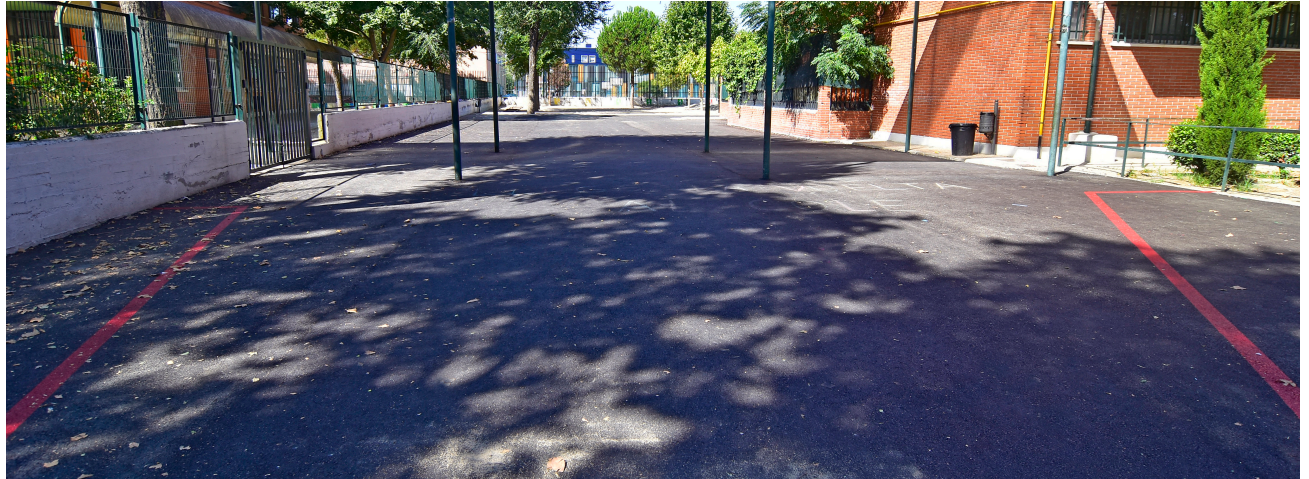
Pavimentación del acceso de la puerta de carruajes
