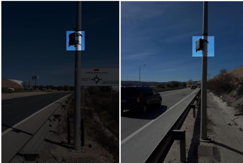
Imagen 6. Aforo automático de tecnología radar ubicado en carretera M-206.
